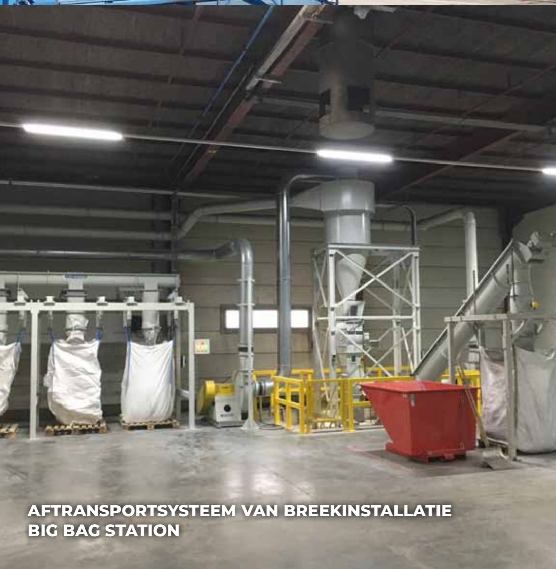
ONTSTOFFING MET PNEUMATISCH TRANSPORT NAAR SILO'S
