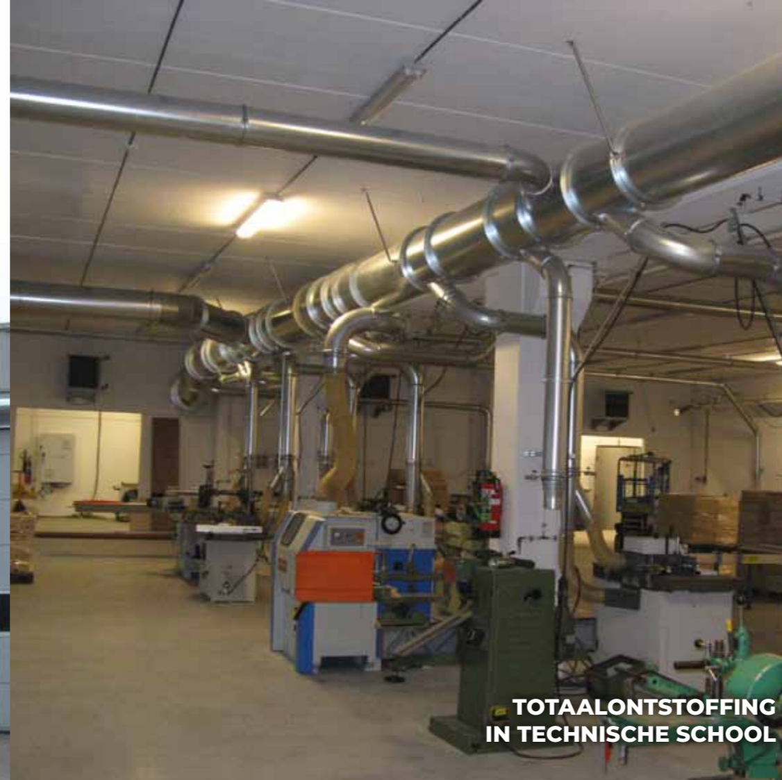
ONTSTOFFING EN GESCEIDEN OPSLAG BIJ SCHAVERIJ
