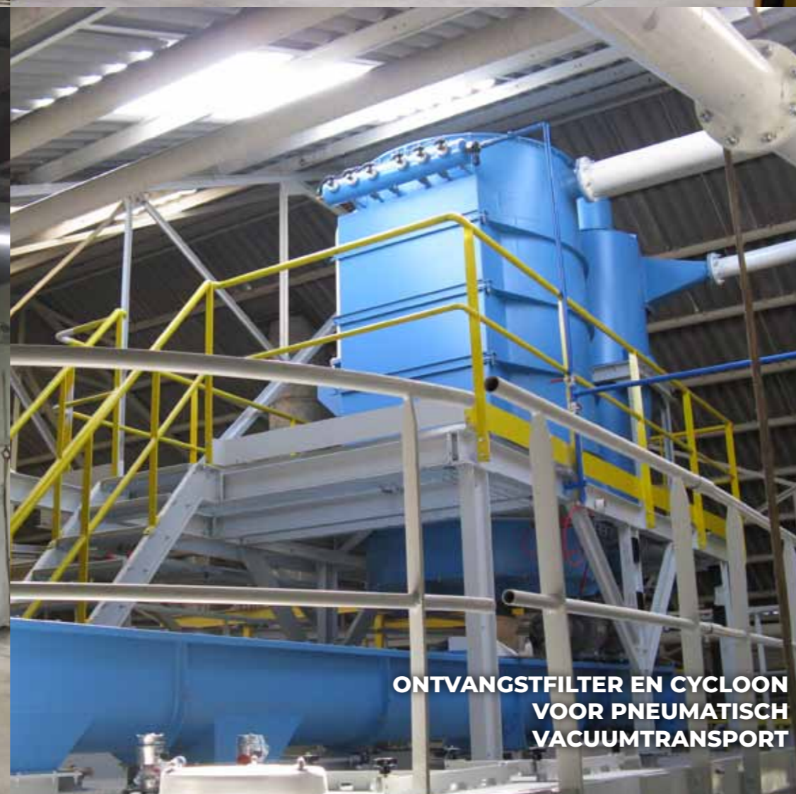
ONTSTOFFING VAN PERSLIJN VOOR ISOLATIEPANELEN
