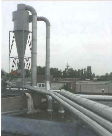
Om wit restmateriaal apart op te vangen, wordt gebruikgemaakt van een voorafscheider op het dak (links)
