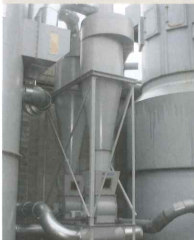
Twee nieuwe transportventilatoren zorgen voor de opsplitsing rood/wit
