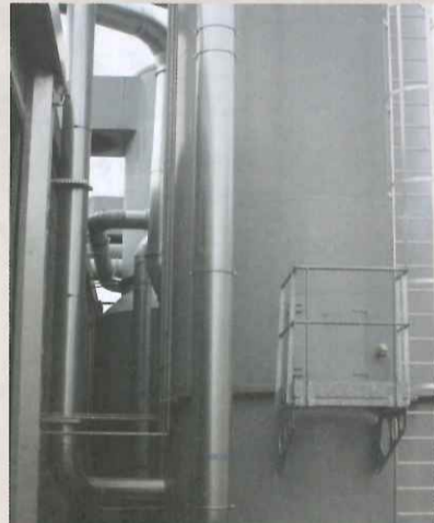
Om wit restmateriaal apart op te vangen, wordt gebruikgemaakt van een voorafscheider op het dak (links)
