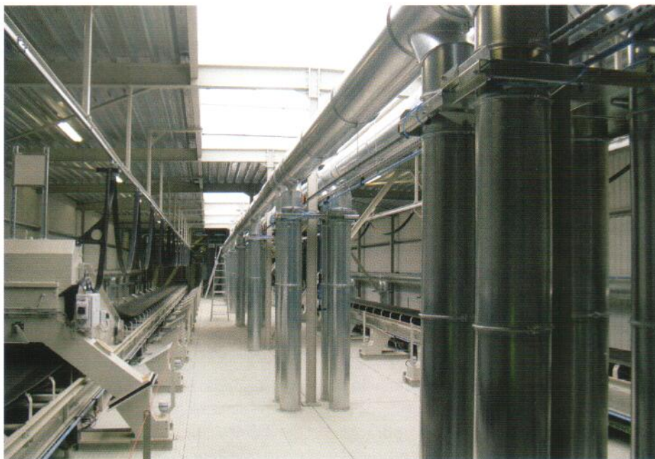
Een ontstoffingsinstallatie van Typhoon voor AVEVE Zaden in Landen (B)
