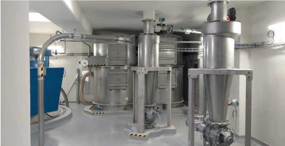
Afb. 2 Pneumatisch transport en diverse ontstoppingen bij thermische behandeling van bloem
