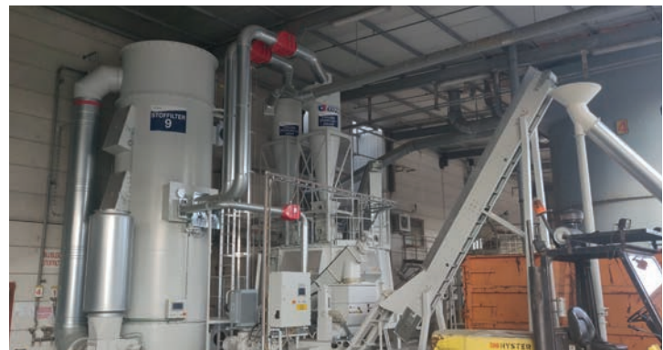
Afb. 6 Afscheiding en opslag van stof, integratie van brikettenpers in de isolatie industrie
